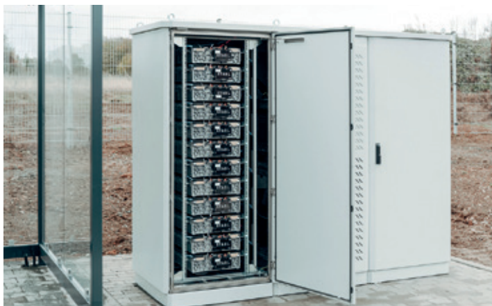
Ein zweites Leben für gebrauchte Batterien aus E-Mobilitätsanwendungen als Speichermodule
